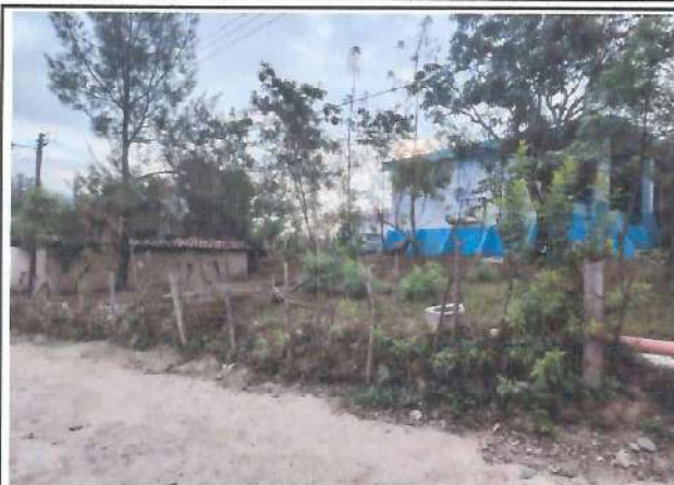
Foto 1: CERRAMIENTO MURO PERIMETRAL DEL CENTRO EDUCATIVO
