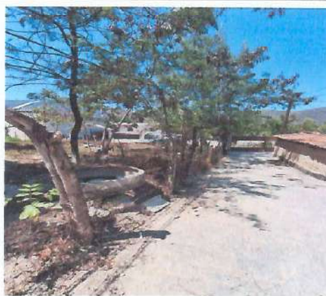
Foto 2: CERRAMIENTO MURO PERIMETRAL DEL CENTRO EDUCATIVO
